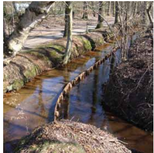
Een schot scheidt het ijzerhoudende water van de Rode Beek van het heldere water van de Nieuwe Beek
